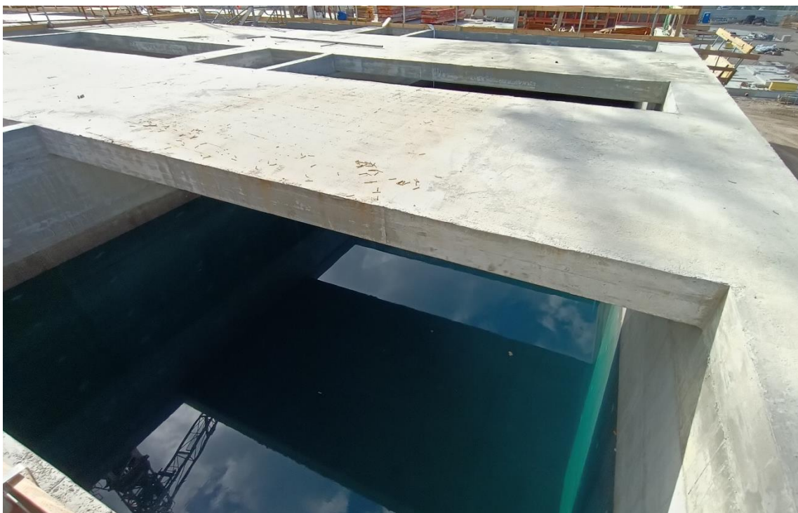
Foto 2: collaudo idraulico delle vasche
