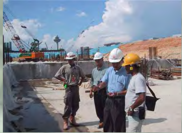
Visione generale del cantiere
