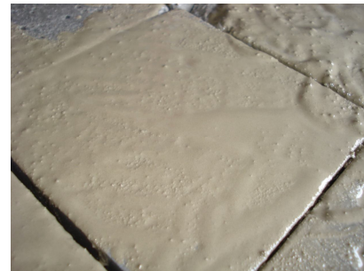
Trattamento a pennello
