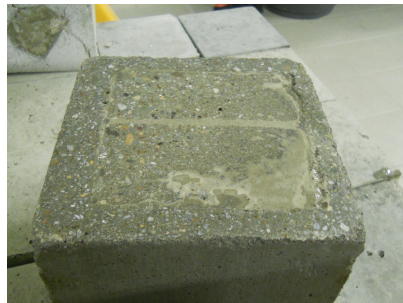
Rimozione dell'eccesso di Penetron mediante fresatura
